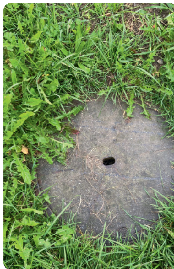
Chiusino problematico con fori di presa aperti. ARENENBERG AFU TG
